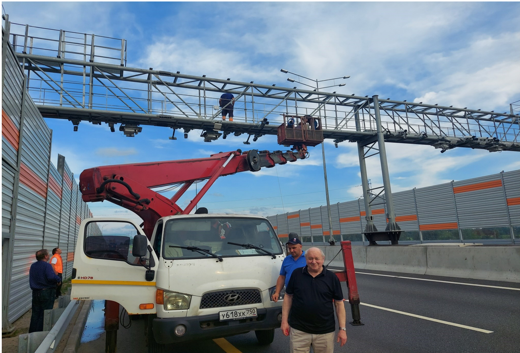
Испытание разработанной системы безопасности на автодорогах. (Центральная кольцевая автодорога, 2021г.)
