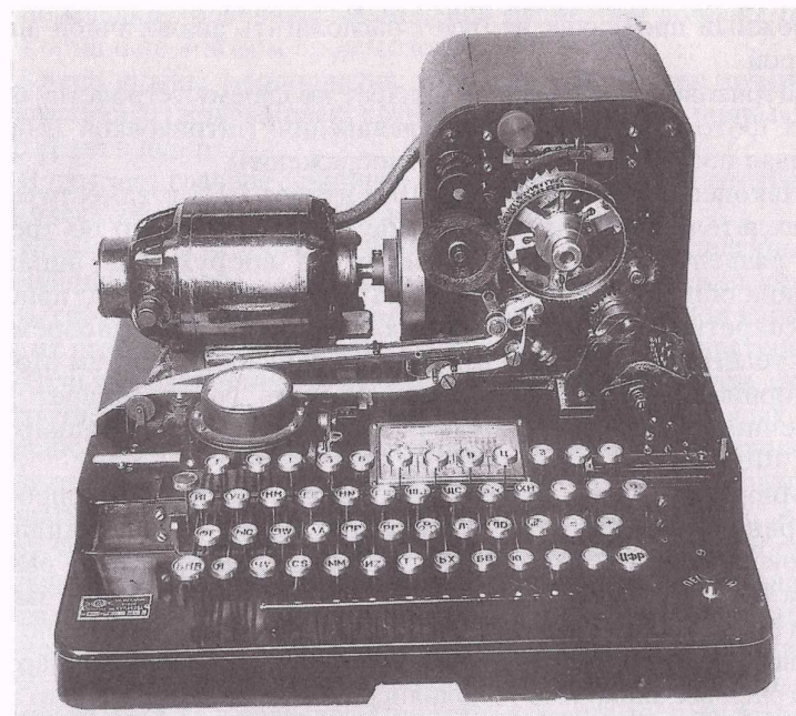
Телеграфный стартстопный аппарат А.Ф. Шорина 1929 г., освоенный в производстве на заводе им. А.А. Кулакова
