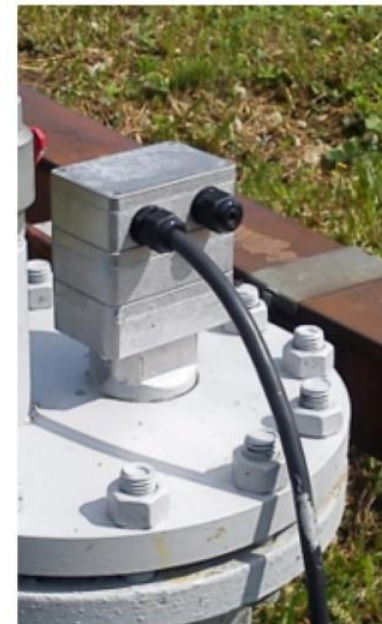
Монтаж датчика ДЖС-7М
