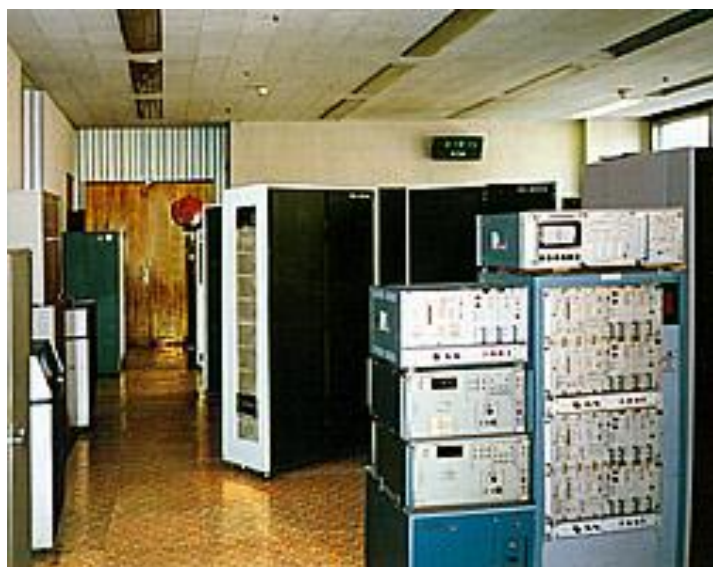
Рис. 5.5. ВК ПС-2000 в ЦУП (тёмные стойки на дальнем плане)
